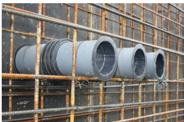
Przykład montażu KRASO® Typ FE: przed betonowaniem
